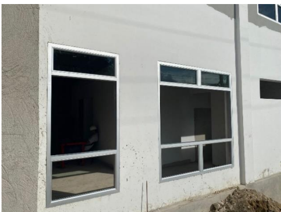
Fotografía 9. Instalaciones ventanería metálica
