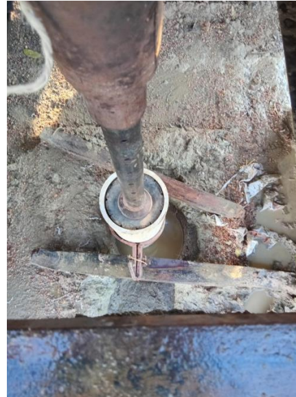
Fotografía 14. Proceso construcción Pozo
