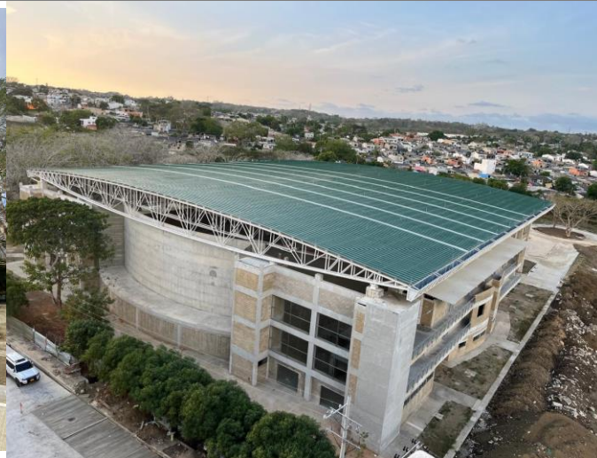
Fotografía 2. Vista Panorámica de la Obra
