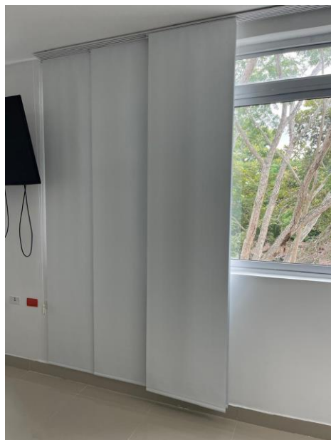
Fotografía 15. Paneles Blackout sala de juntas
