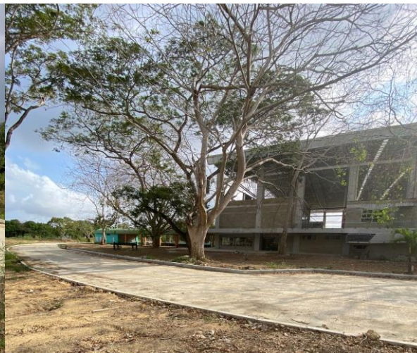
Fotografía 12. Pavimento en concreto rígido.
