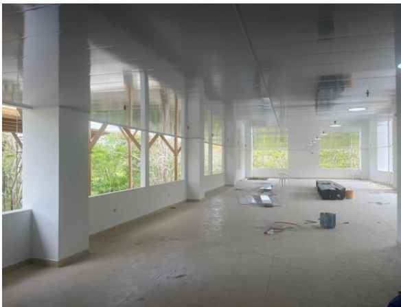
Fotografía 3. Instalación de acabados y cielo raso en segunda planta
