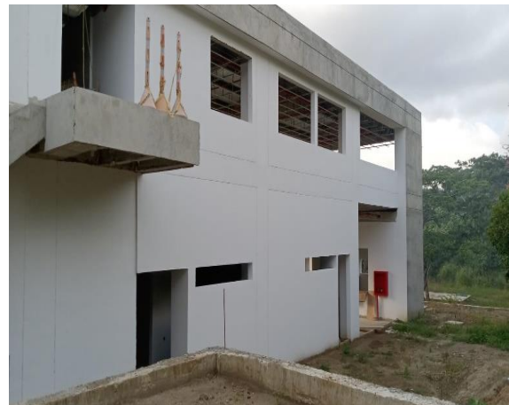
Fotografía 4. Fachada posterior, avances acabados
