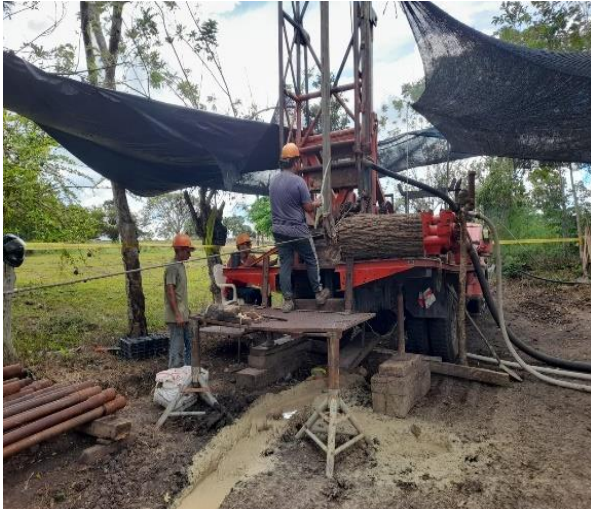
Fotografía 13. Maquinaria construcción Pozo
